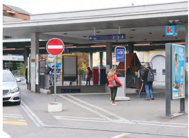
Abbildung 22: Personenunterführung Bahnhof Mitte.
