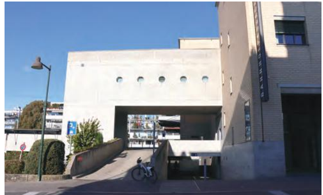
Abbildung 21: Personenunterführung Bahnhof West.
